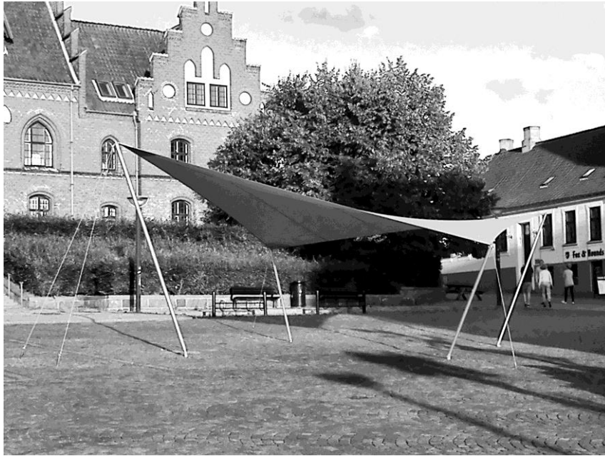
Рис.1. Тентова конструкція зони відпочинку у центрі міста Roskilde, Denmark
